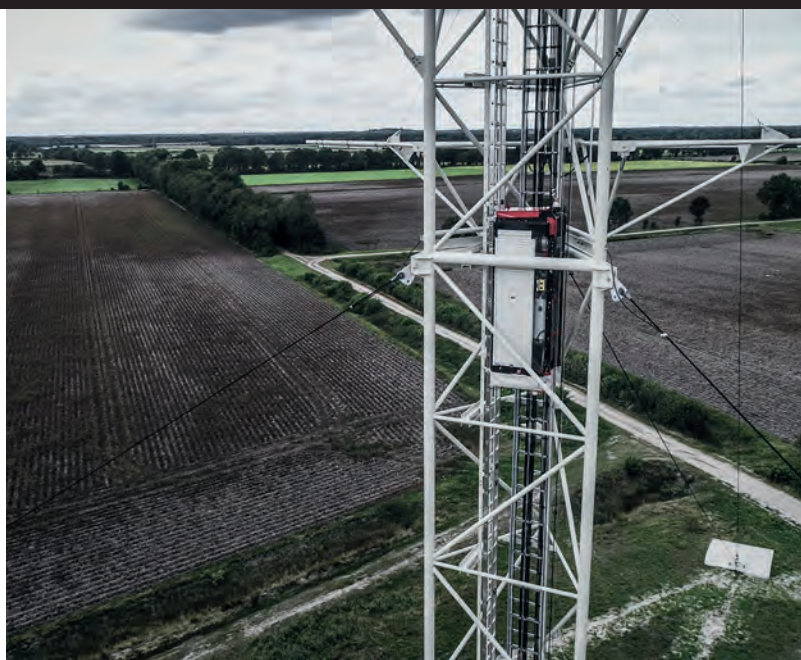
Stahl-Wettermast (Meppen), TOPlift, 80 m Turmhöhe
